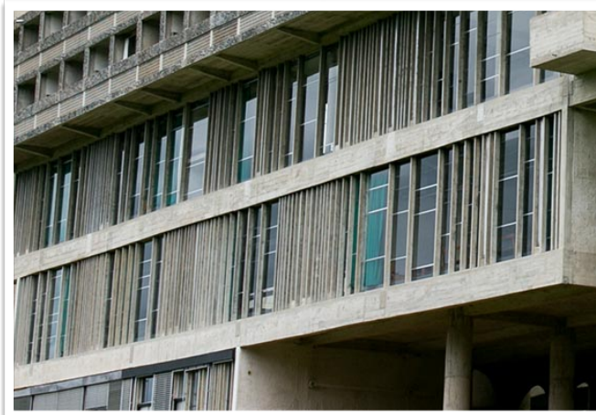
Couvent de la Tourette, pans de verre ondulatoire facade ouest
